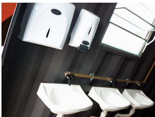
Contêiner banheiro feminino
