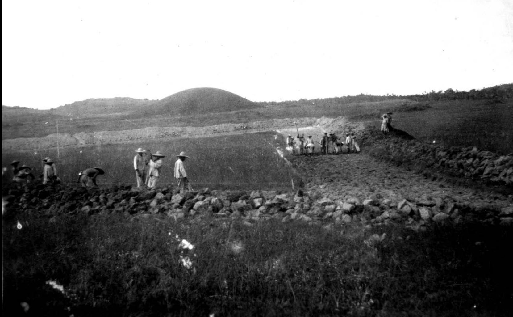
Construção do sinal aerofotogramétrico no campo de Paraguaimá, próximo do marco 9 - Venezuela - 4 84 C
