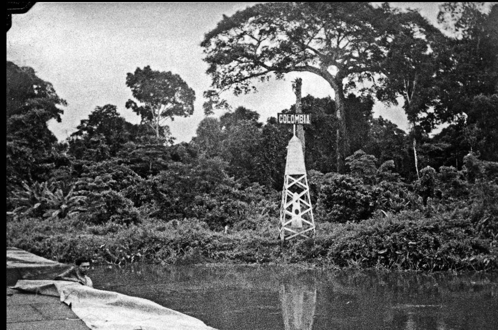
Marco e sinal da margem direita do Rio Içá. Vê-se a margem do Rio corroída pelas águas avançar para o marco, 1935 - Colombia
