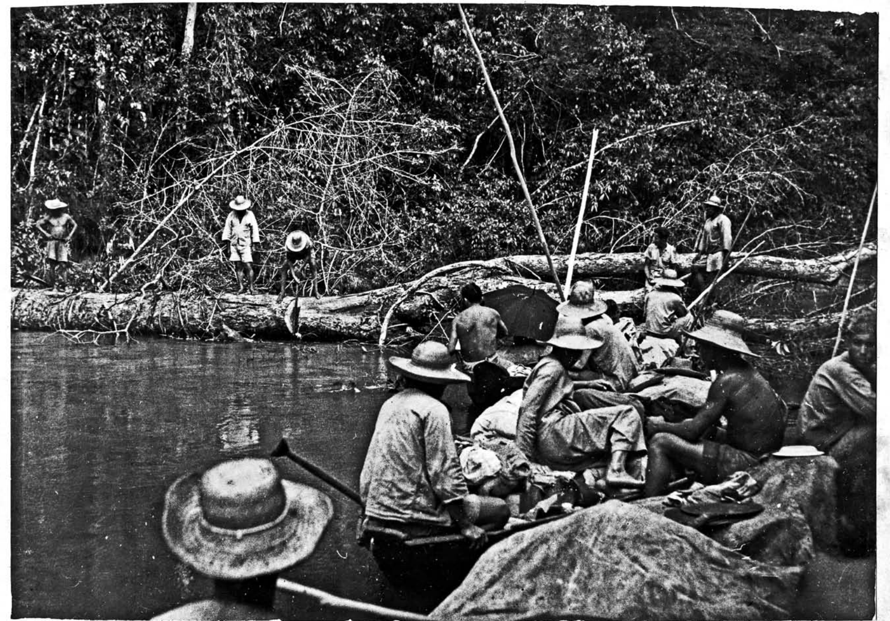
Desobstrução no Rio Juruparu
