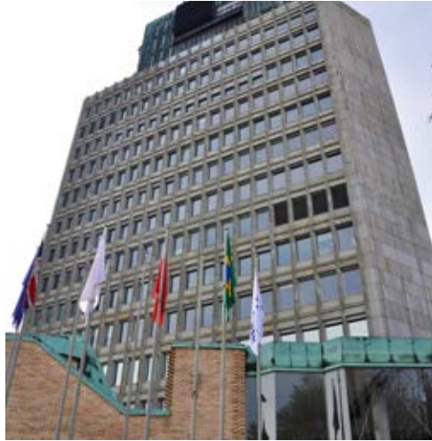
Edifício em que se localiza a Embaixada do Brasil em Liubliana (Eslovênia). Foto cedida pelo posto.
