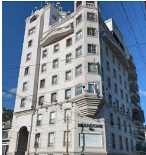
Edifício em que se localiza a Embaixada do Brasil em Porto Príncipe (Haiti). Foto cedida pelo posto.
