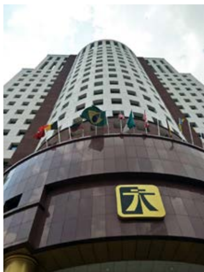
Edifício em que se localiza a Embaixada do Brasil em Kuala Lumpur (Malásia).
