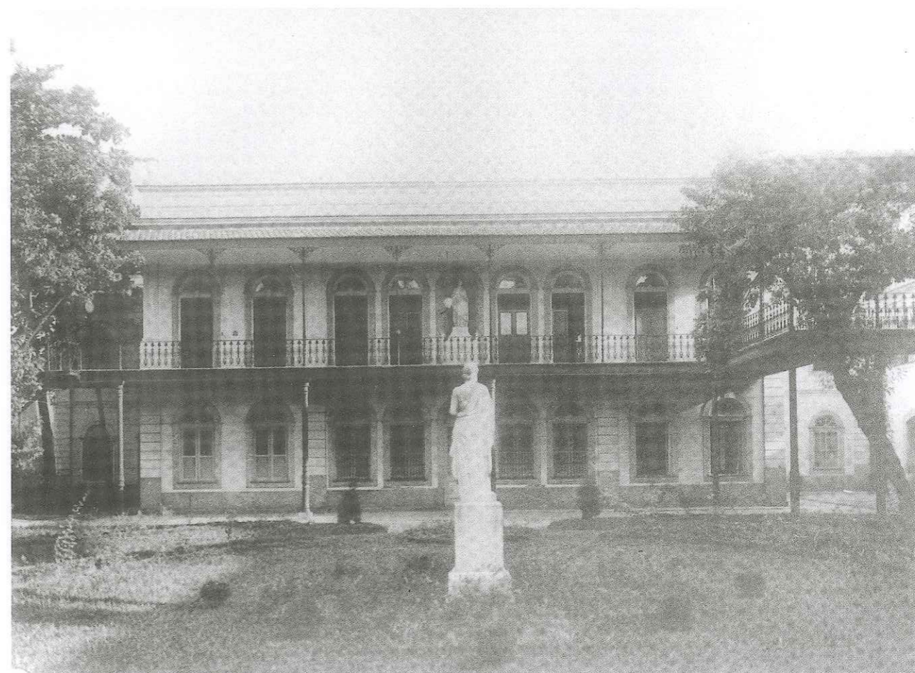
A fachada posterior do Palácio Itamaraty na época do Barão.
