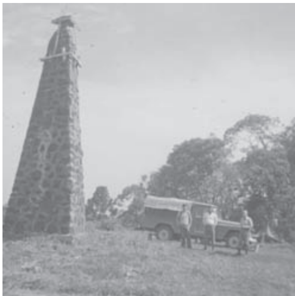
Marco da Cabeceira do Rio Peperí-Guassu, já com a antena colocada. Ao fundo, o pequeno caminhão da empresa Geocarta, com a aparelhagem em funcionamento. O Marco parece estar torto, mas não está. O defeito foi do fotógrafo, que era primário.
