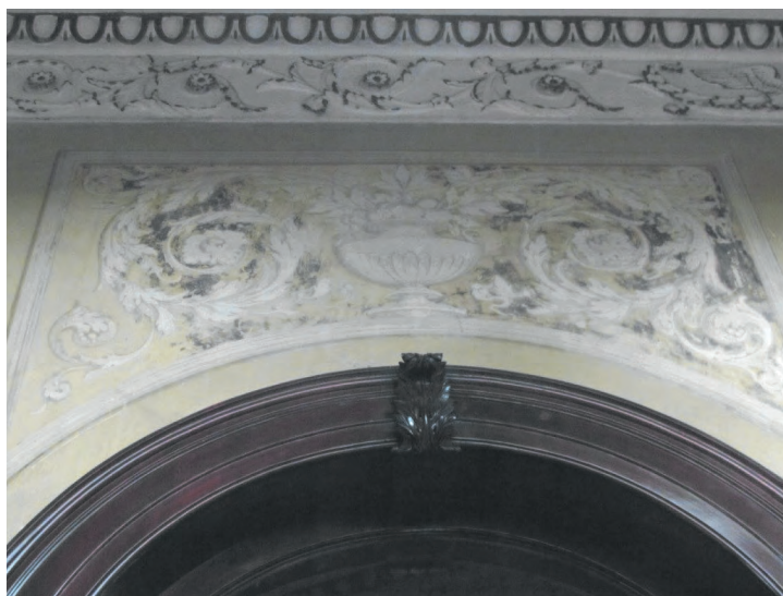
Figura 11 – Hall de Entrada em 11/12/12
