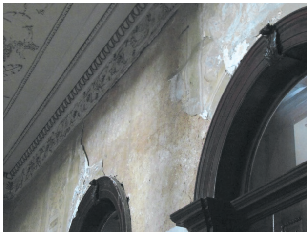
Figura 9 – Hall de Entrada em 11/12/12
