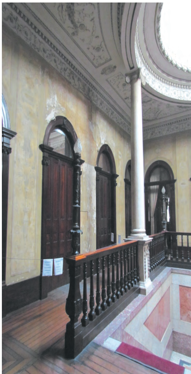
Figura 8 – Hall de Entrada em 11/12/12
