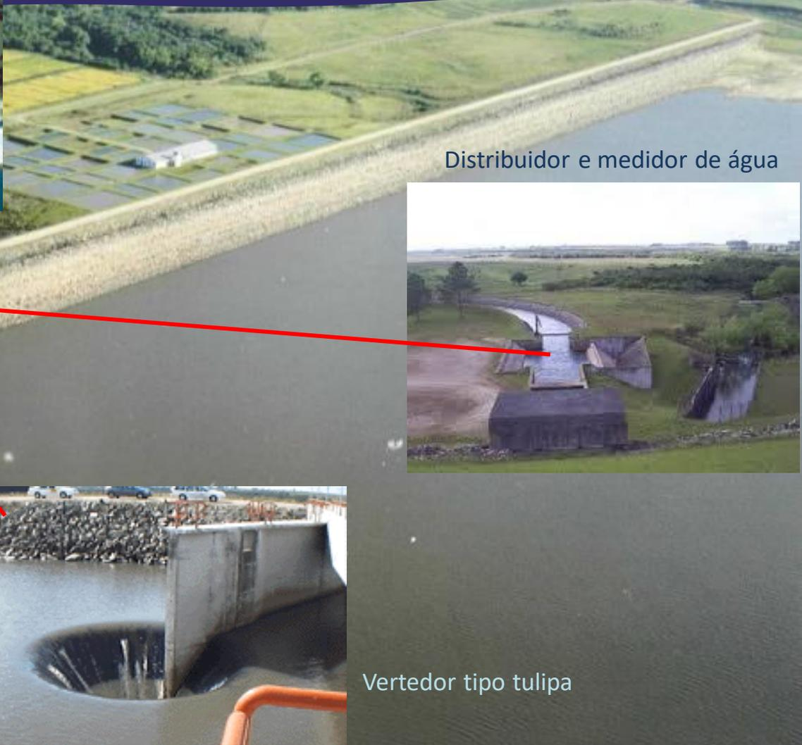
Distribuidor e medidor de água
